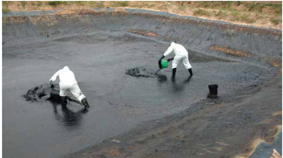
Conformación de celda de lodos empetrolados
