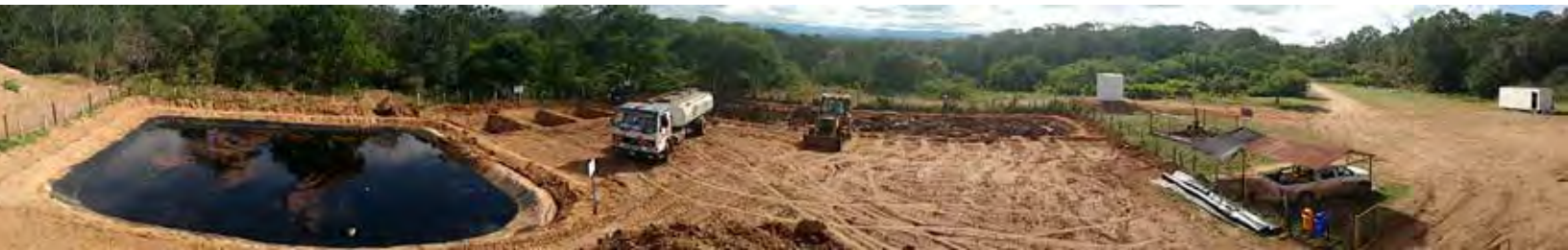
Trabajos de biorremediación en áreas operativas
