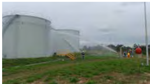
Combate contra incendio en tanques de petróleo
