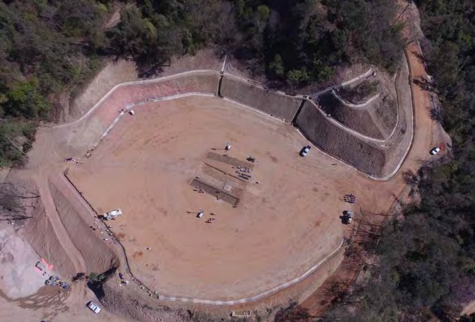
CONSTRUCCIÓN DE CAMINO DE ACCESO Y PLANCHADA POZO LMS-X12, CAMPO LOS MONOS
