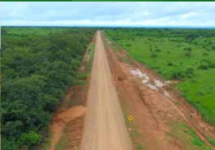
Camino de Acceso hacia la Planchada COL-10
