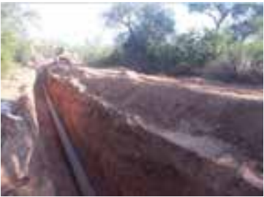
Excavación y Tendido de Línea Regular
