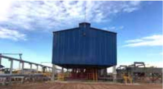
Galpón de Nuevos Compresores en Planta Percheles
