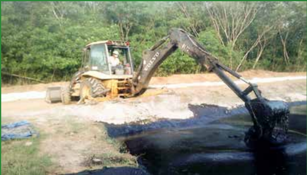
Trabajos de Degradación de Lodos Empetrolados
