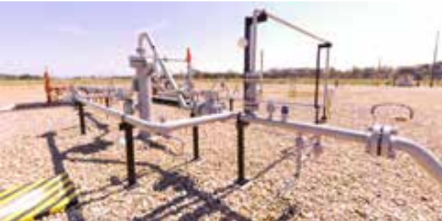
Desarenador del Pozo COL-4H
