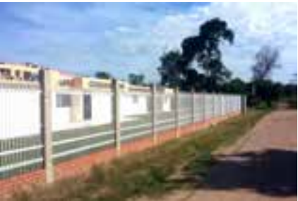
Campo: PCH-DRD Proyecto: : Enmallado Perimetral Materno Infantil Beneficiarios: Municipio de Cabezas. Comunidad Mora
