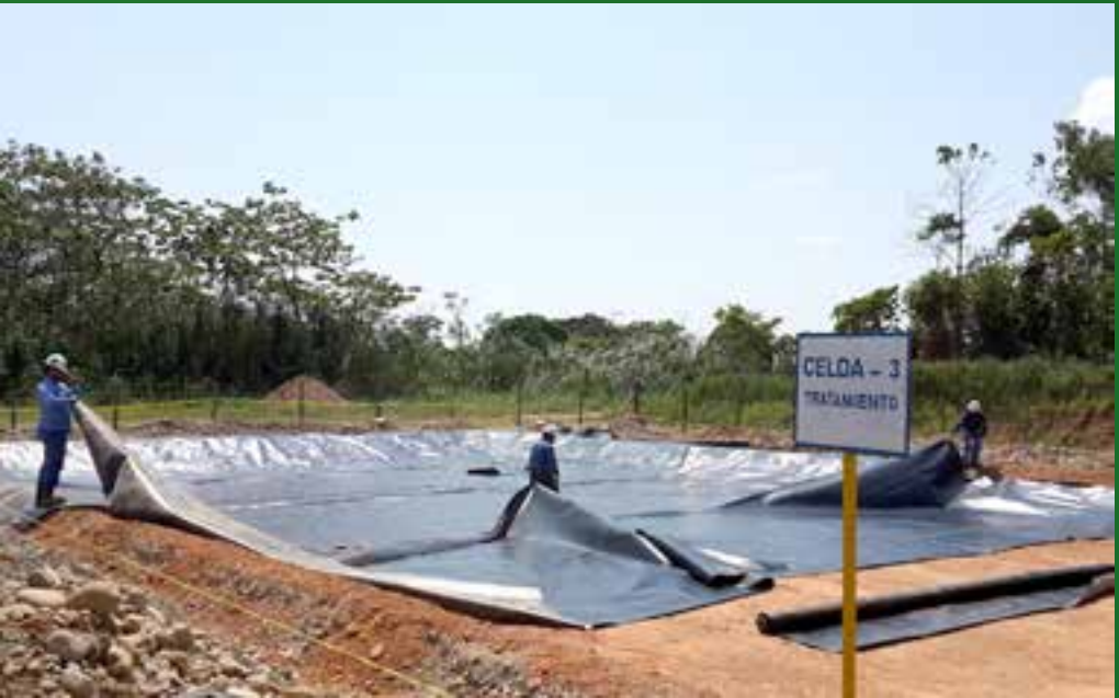
Conformación de celda de lodos empetrolados
