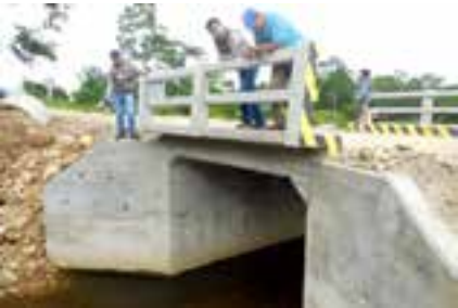
Campo: CRC-KNT-BBL Proyecto: Construcción Puente Muñecas Beneficiarios: Municipio de Entre Ríos. Distrito IV Manco Kapac. Central 21 de Septiembre
