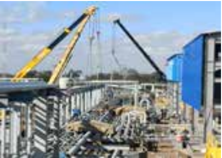
Soldadura en Parrales de Planta Percheles
