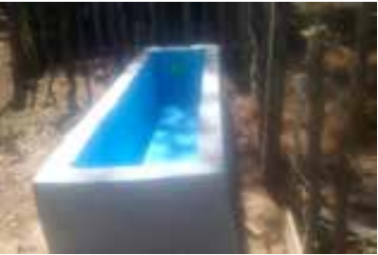
Campo: LMS Proyecto: Construcción de aljibes para captación de agua Beneficiarios: Municipio de Villa Montes. Capitanía La Costa
