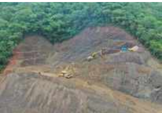
Trabajos en Planchada para el Pozo LMS-X13D
