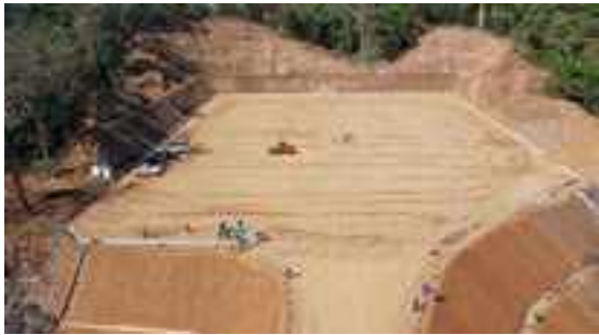
Trabajos en Planchada Pozo SRS-12D
