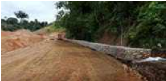
Vista del Camino y Construcción de muro de gavión
