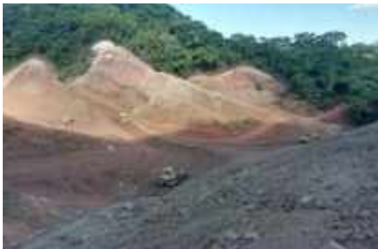
Trabajos en Planchada para el Pozo ITY-X1
