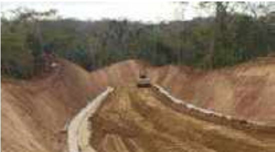
Perfilado del Camino, Taludes y Cunetas Revestidas
