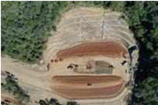
Conformación de Terraplén en Planchada AGC-X1
