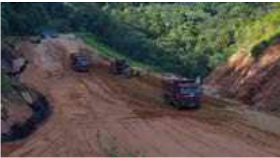
Trabajos en Camino de acceso Pozo SMG-X2ST
