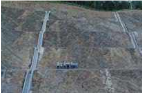
Bajantes HoAo y taludes en Planchada Pozo AGC-X1
