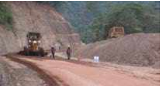
Trabajos en Camino de Acceso
