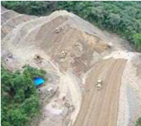
Extendido y Compactado de Capa Base en Movimiento de suelo en Planchada
