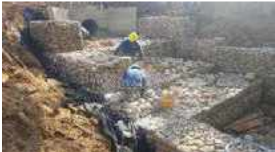
Construcción de Gaviones y Colchonetas
