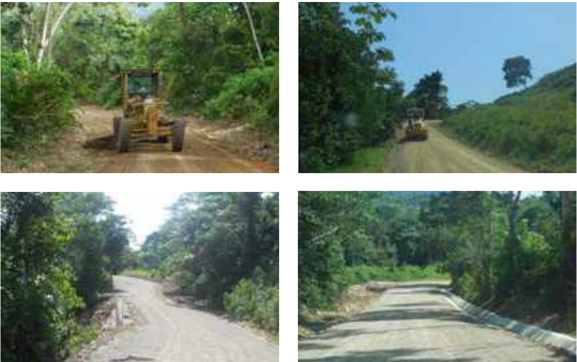
Campo: BBL Proyecto: Mantenimiento de Caminos Tramos Bulu Bulu Beneficiarios: Municipio de Entre Ríos.
