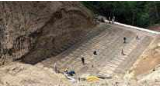
Muros de contención con Suelo Armado
