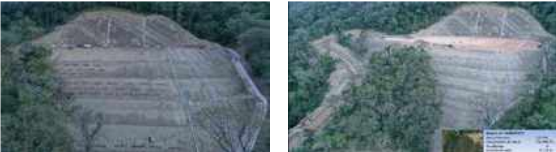
Vista General de Taludes de corte y relleno en Planchada Pozo AGC-X1
