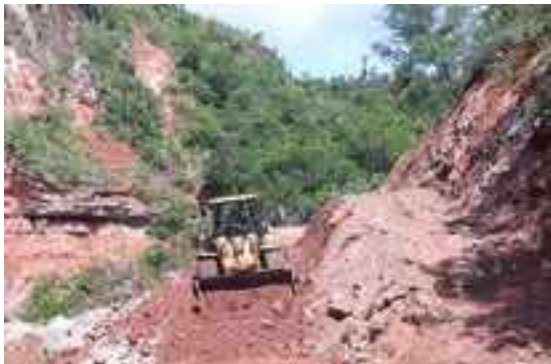
Trabajos en Apertura de Camino
