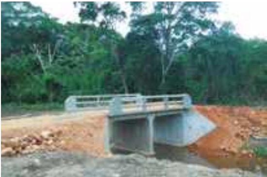
Campo: CRC-KNT-BBL Proyecto: Construcción Puente Ñ Lauca Beneficiarios: Municipio de Entre Ríos.
