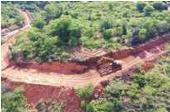
Vista de construcción de camino
