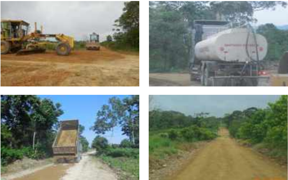
Campo: CRC-KNT Proyecto: Mantenimiento de Caminos Tramos Carrasco - Kanata Beneficiarios: Municipio de Entre Ríos.
