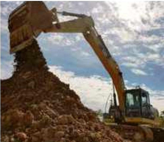
Homogenización de suelos contaminados
