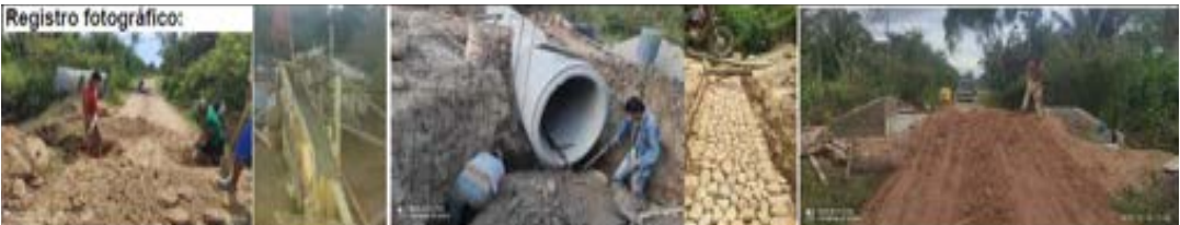
Campo: JNN Proyecto: Mantenimiento de camino La Palca - La Planchada Beneficiarios: Municipio de Santa Rosa del Sara.
