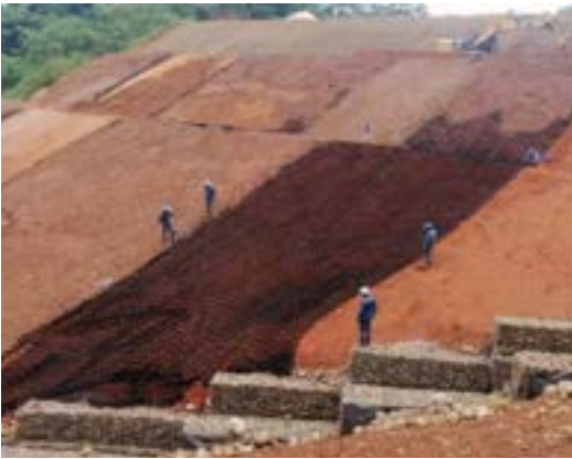
Conformación y Restauración de Taludes en Planchada SMG-X2 ST2
