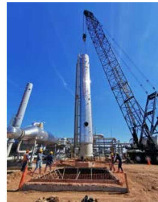
Izaje de Torre Regeneradora en Planta La Vertiente
