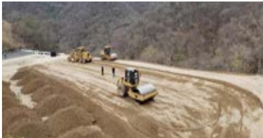
Conformación de Terraplén Planchada LMS-X13
