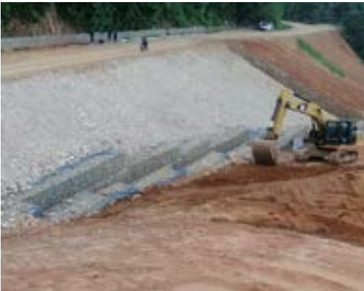
Construcción de Gaviones en Planchada SMG-X2 ST2
