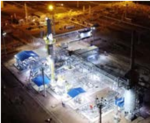
Vista Aérea Planta de Amina en La Vertiente
