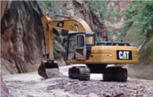
Crecida de la quebrada, trabajos de recomposición y habilitación del Camino de Acceso LMS-X13D
