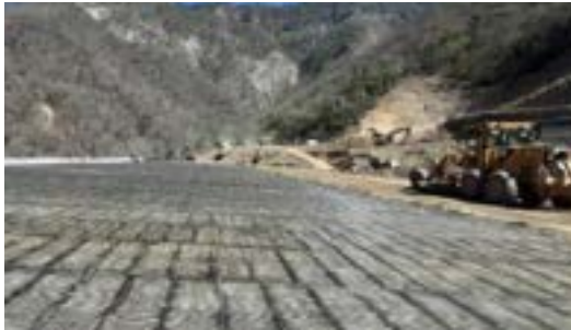
Conformación de Suelo Armado en Planchada LMS-X13
