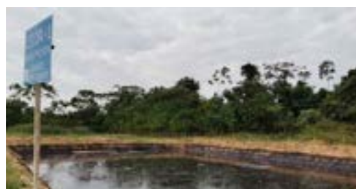
Celda N° 1 de recepción de lodos/liquidos cotaminados con hidrocarburos
