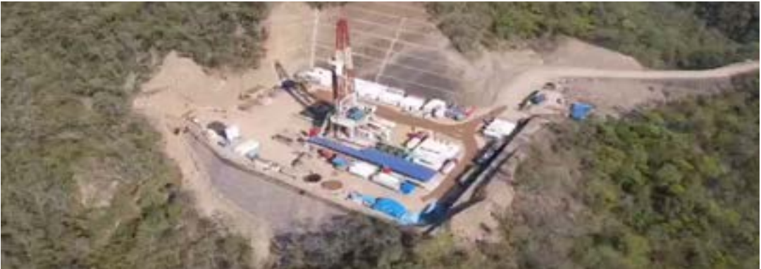
Vista Aérea de la Planchada LMS-X13D con el equipo de Perforación
