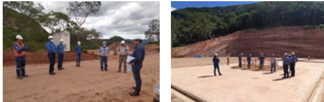
Campo: ITY-X1 Proyecto: Construcción Camino y Planchada Beneficiarios: Municipio de Villa Vaca Guzmán.
