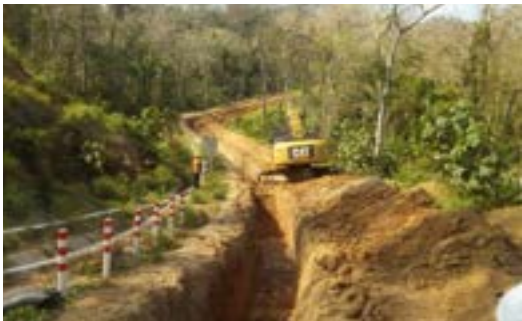
Excavación de zanja en camino de ingreso a pozo SRS-12 para el tendido de las Líneas de Recolección
