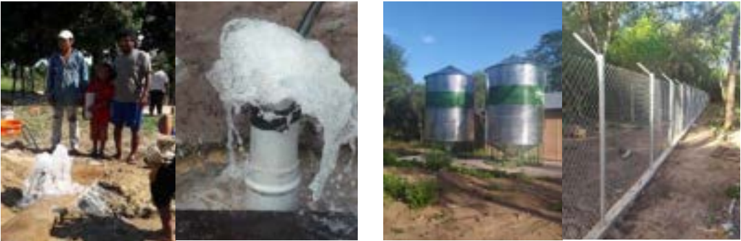
Campo: HSR-JNN-PJS-SRS Proyecto: Perforación de Pozo de Agua Lomerio I Beneficiarios: Municipio de Santa Rosa
