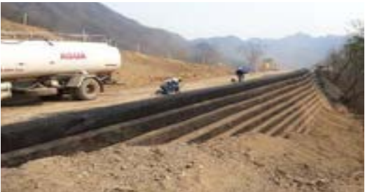
Conformación de Suelo Armado camino de acceso a LMS X13
