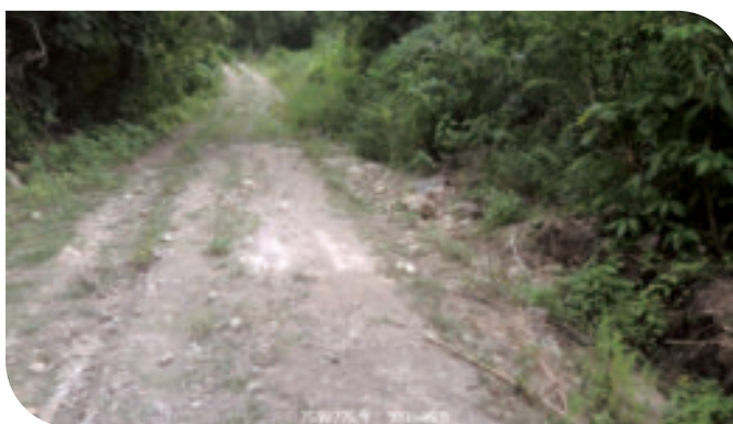
Camino Existente Astillero
