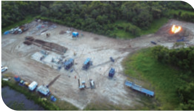
Construcción de facilidades SIG, en paralelo a las pruebas de producción de pozo extendidas
