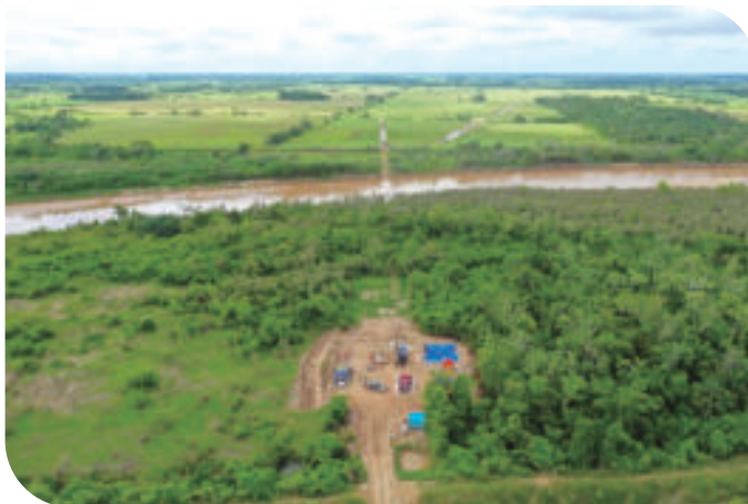
Construcción del cruce del Río Piráí con perforación horizontal dirigida
