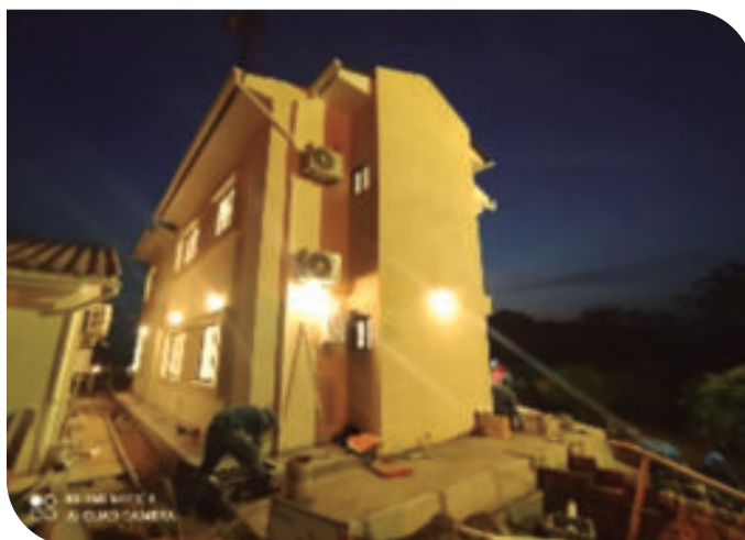
Construcción Edificio Campamento SRS
