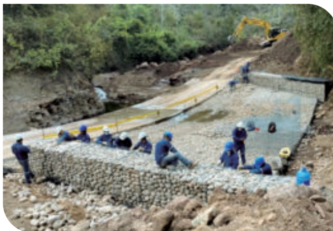
Construcción Baden Cruce de Quebrada CAI # 3
