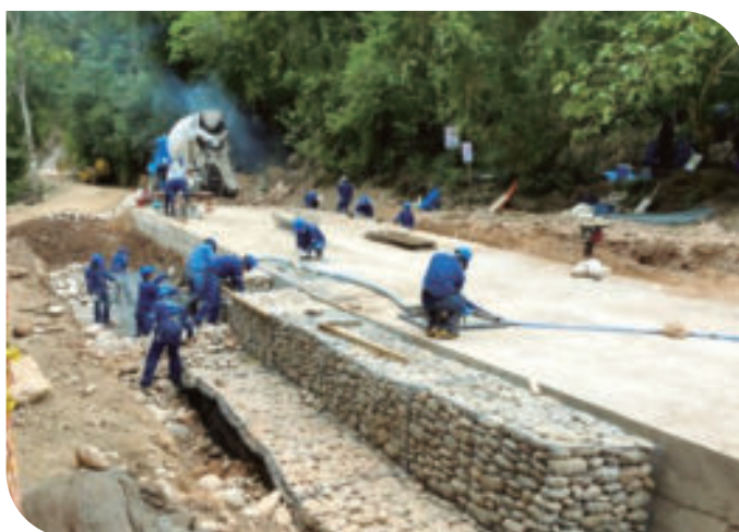
Construcción Baden Cruce de Quebrada CAI # 1
