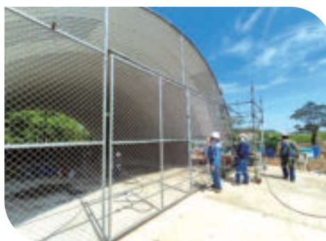
Fase de Construcción Cerramiento Lateral
