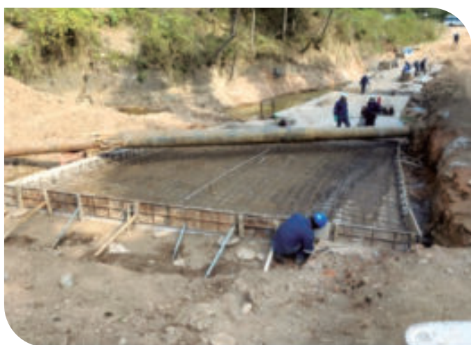
Construcción Baden Cruce de Quebrada CAI # 2
