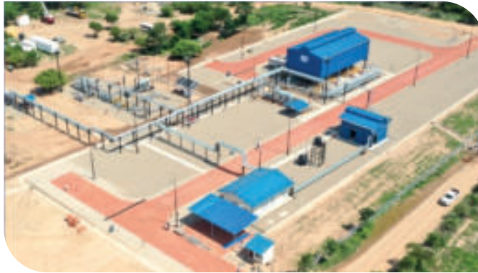
Vista de sala de control, sala de generación eléctrica, parqueo y portería
