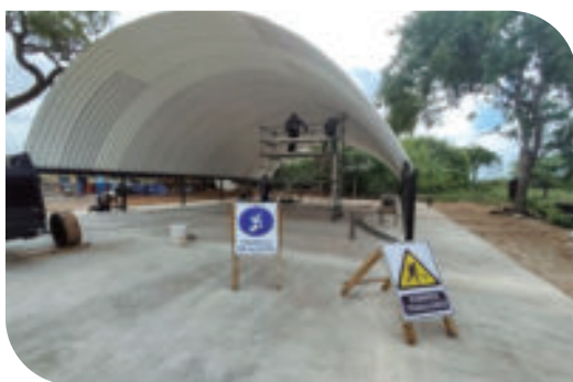
Montaje de Cubierta Auto Portante
