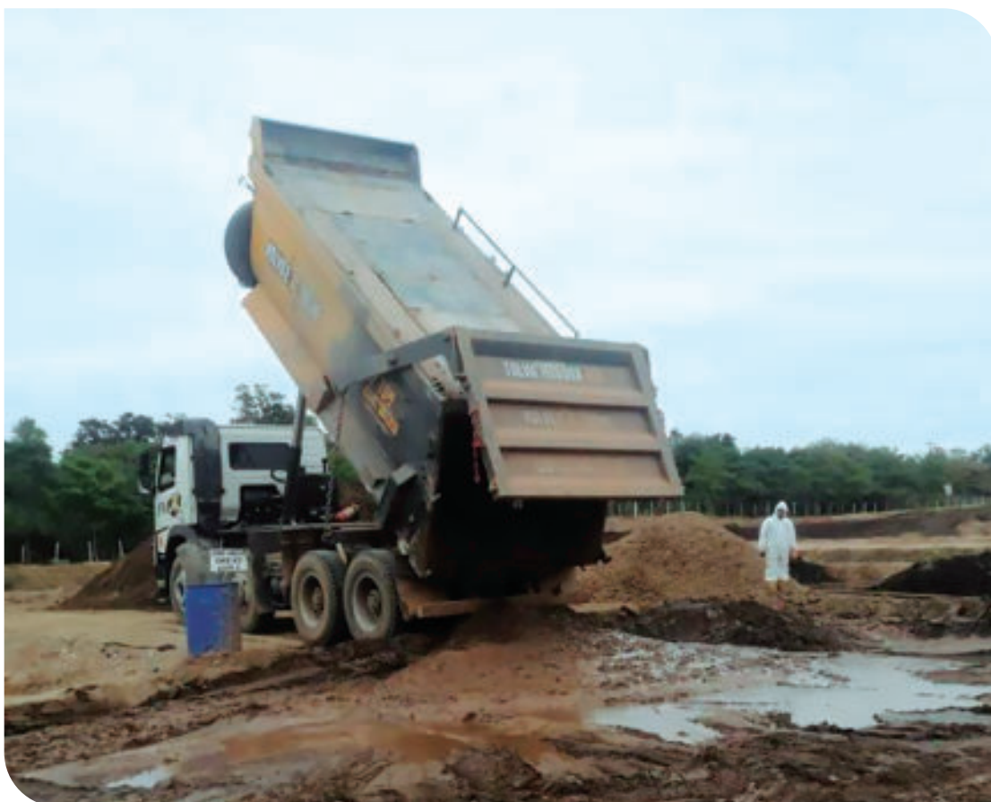
Descarguío de lodos del Pozo SMG-X2 en predio de tratamiento del contratista
