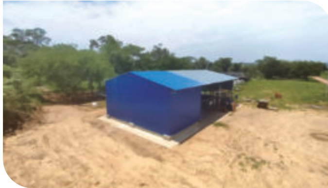
Ampliación Galpón Existente
