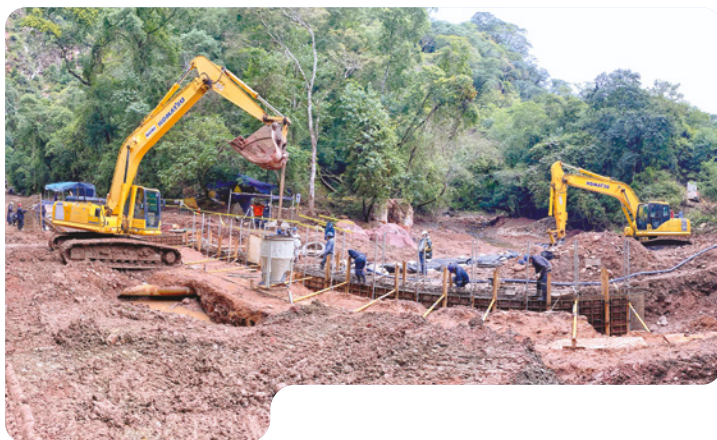
Construcción de badenes
