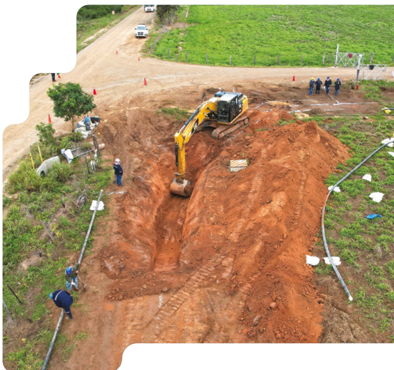
Construcción de línea troncal y facilidades para pozo FLA-3H
