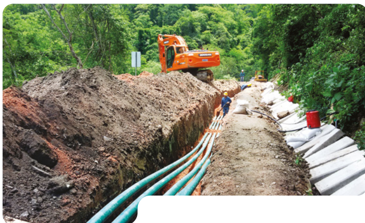
Cambio de líneas flexibles
